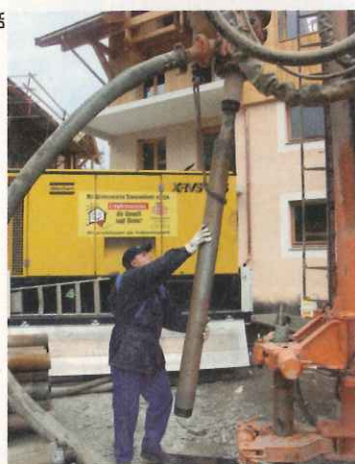
Installation des conduites d'eau.
